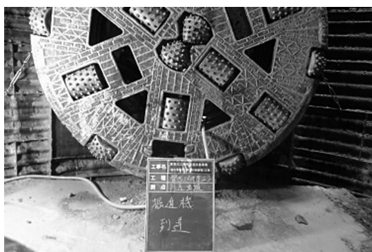
写真-22 掘進機到達状況
