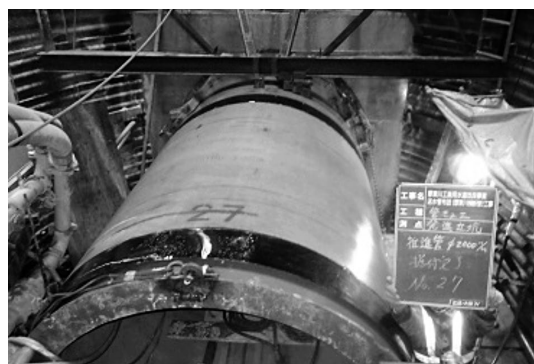
写真－18 推進施工状況
