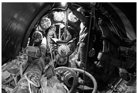
写真-21 ゲージカッタの交換作業状況
