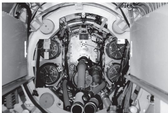
写真-5 機内の点検扉
