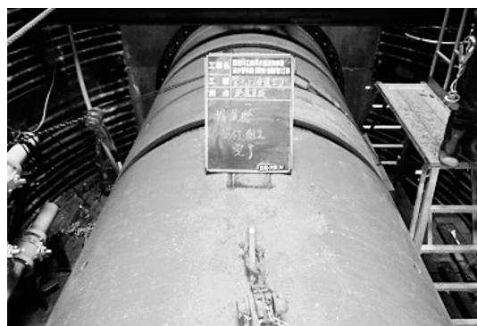
写真－17 CMT掘進機据付
