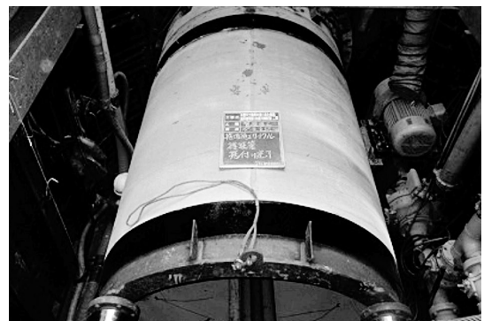
写真-14 推進施工状況
