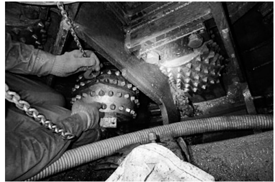
写真-12 ゲージカッタ交換状況
