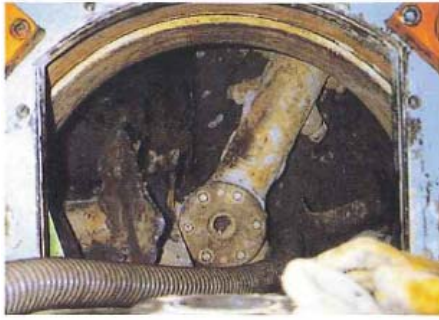
点検扉より銅矢板切断撤去
