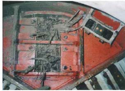
スリットに流木・閉塞確認、その後撤去します
