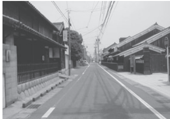
写真-1 一般全景
